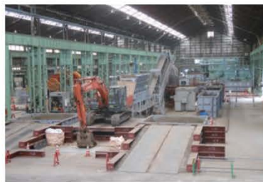
オンサイト土壌洗浄工法
