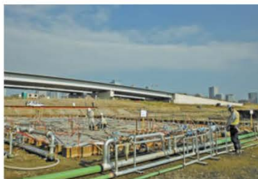
原位置浄化工法 (注水バイオスパーキング工法)
