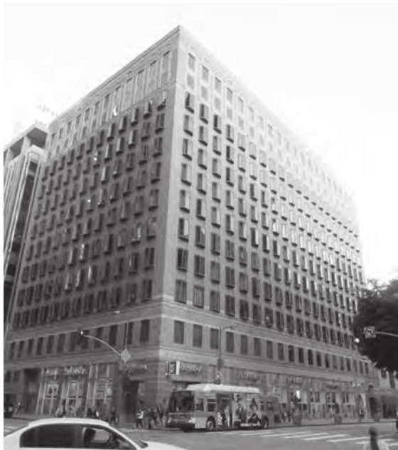
図－9 617 West 7 th Streetビル Listedには該当しないがEBOM Gold認証を取得したロングライフビルの例（1911年建設、2001年改修）。外装サッシが更新されている。
