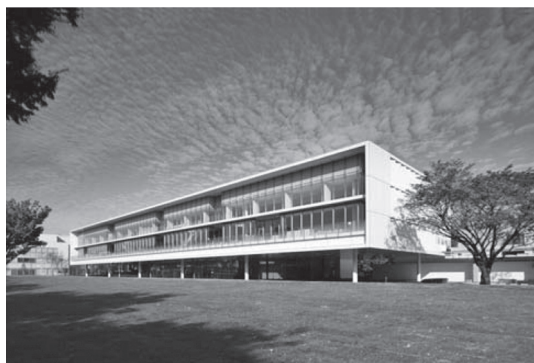
写真-1 建物外観
