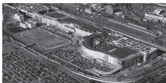
写真-1 建物外観
