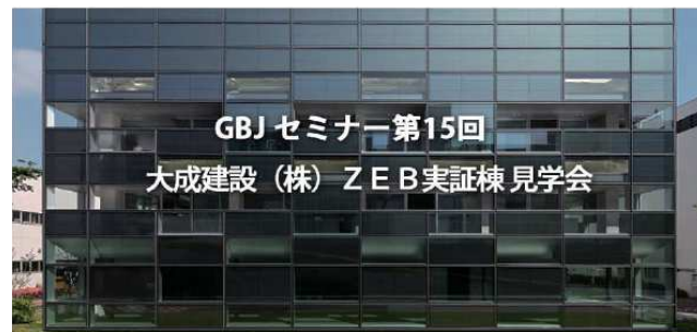
大成建設技術センターZEB実証棟 LEED-NC v2009 Platinum https://www.gbj.or.jp/seminar15data/
