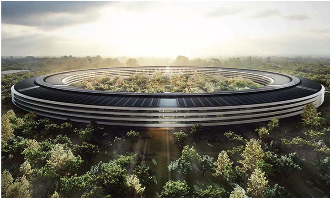
ESBより広い延床面積280万SF(26万㎡)805,000sf(74,800㎡のPV)ほとんどを再生可能エネルギー,年間通して9ヶ月間は暖房なし、A/Cなし、6,000本の樹木。世界最大の自然換気建築
