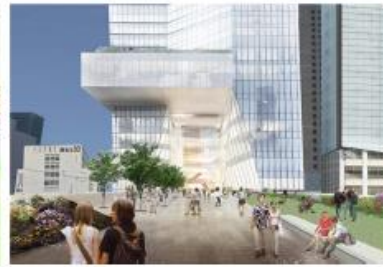
国道1号上空部分
