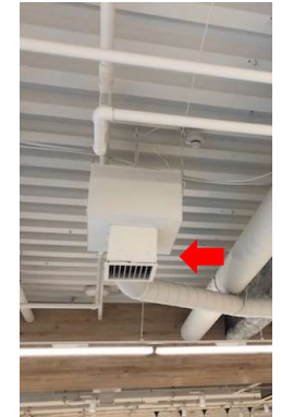
設置換気口(排気)
