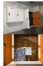
①1階分電盤内に収納された、計量用バッグにゴミを入れる。
