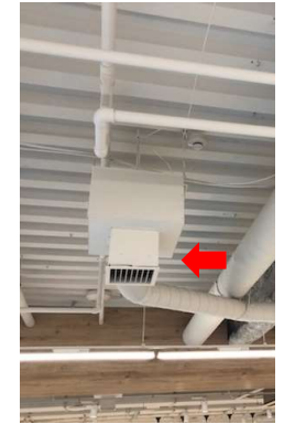
設置換気口(排気)
