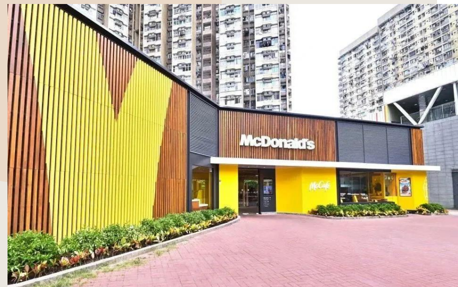
マクドナルド香港太和店 LEED O+M:EB Platinum, LEED ZERO CARBON 2022 年 香港
